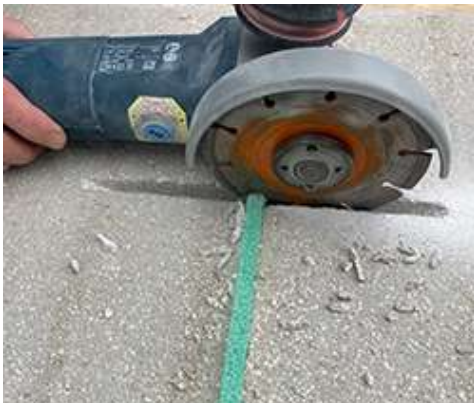
A dübel helyének kivágása esztrich tágulási hézagjára merőlegesen
