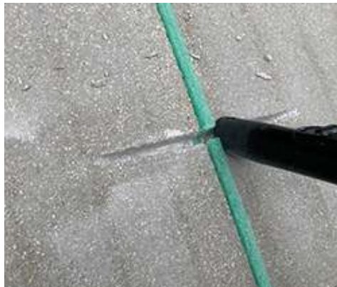
A dübel fogadására kialakított hézag
