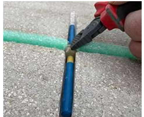
A feszítőgyűrű eltávolítása az expanziós habról
