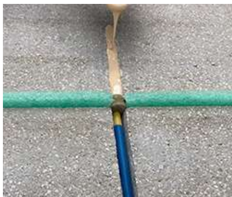
A dübel kiöntése
