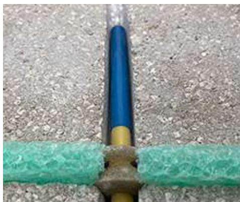
Az esztrich dilatációs dübel beillesztése a helyére
