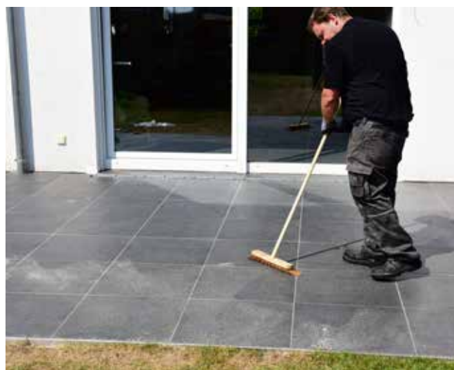
16 ... és adott esetben az anyagmaradványokat söpörjék össze kókuszseprűvel!
