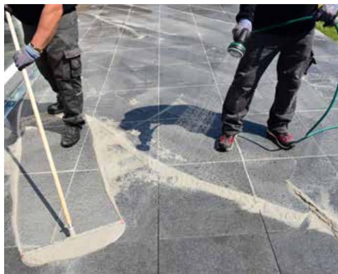
14 A felületet a fugázás alatt végig tartásuk nedvesen!
