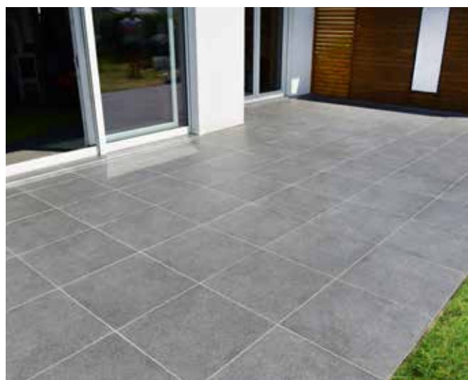
18 A kifugázott felület 24 óra elteltével járható.D
