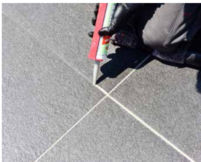
17 Fugázzák ki a csatlakozó és mozgó fugákat!
