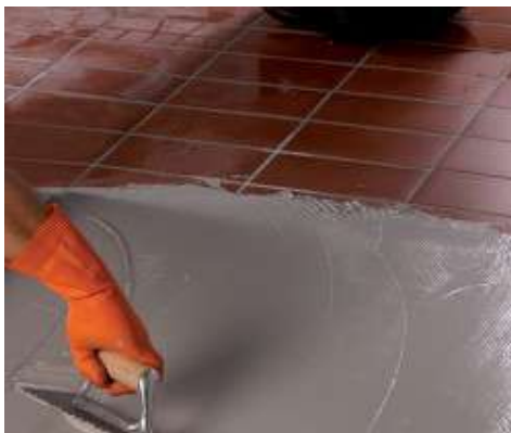
Második réteg Monolastic felvitele Mapenet 150-re
