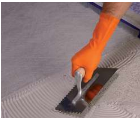
Monolastic első rétegének felvitele új esztrichre Mapetex Sel erősítéssel
