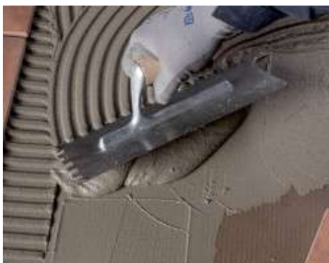
Mapenet 150 elhelyezése a Mapelastik Turbo első rétegébe amíg az még nedves
