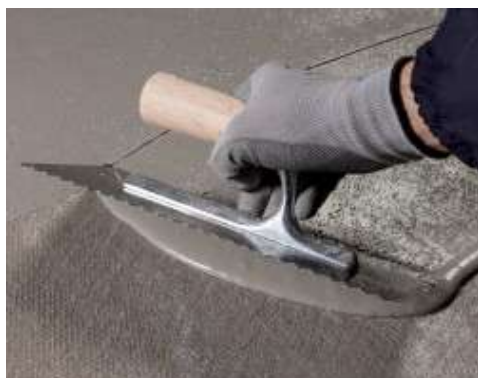
A második réteg Mapelastik Turbo felhordása az első, Mapetex Sel-lel erősített rétegre
