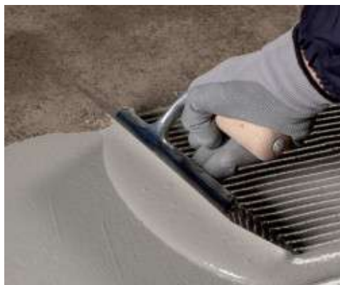
A Mapelastik Turbo első rétegének felhordása
