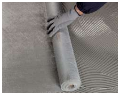
Mapetex Sel elhelyezése a Mapelastik Turbo első rétegébe amíg az még nedves
