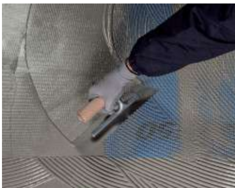
Mapenet 150 elhelyezése a Mapelastik Turbo első rétegébe amíg az még nedves
