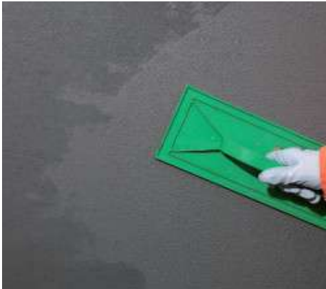
A Mapegrout 430 besimítása
