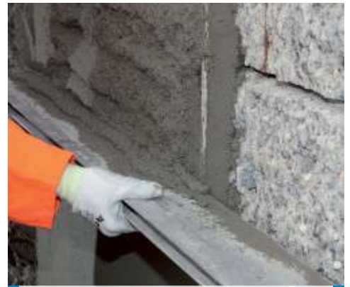
A Mapegrout 430 simítása sima simítóval
