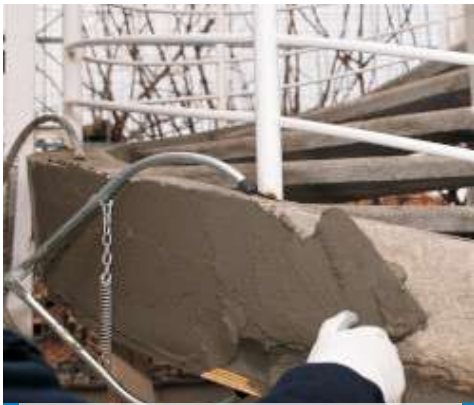
A Mapegrout 430 bedolgozása simítóval
