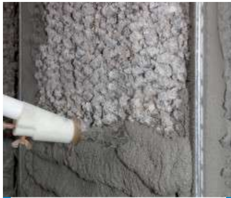
A Mapegrout 430 bedolgozása szórással
