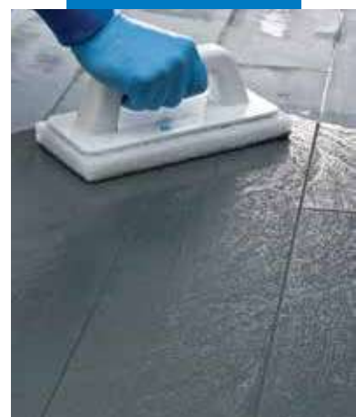
Fugák tisztítása Scotch-Brite®-tal (ha a termék már részben megkötött)
