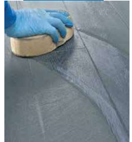
Fugázóhabarcs lemosása és végtisztítása kemény cellulóz szivaccsal
