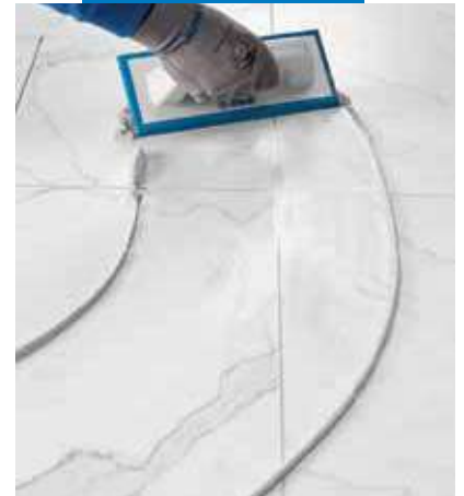
Ultracolor Plus terítése padlón gumisímitóval
