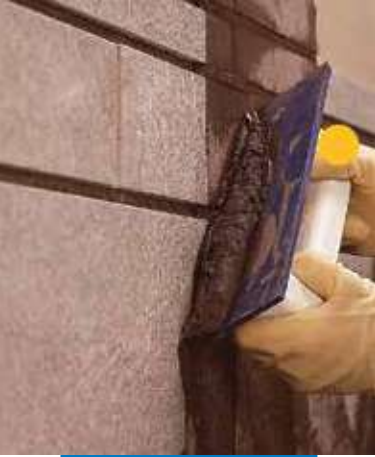
Ultracolor Plus felhordása falra gumilehúzóval
