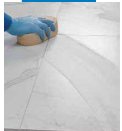
Fugázóhabarcs tisztítása és végtisztítása szivaccsal
