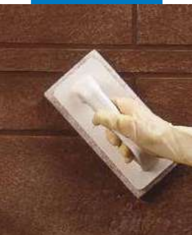
Fugák tisztítása Scotch-Brite®-tal (ha a termék már részben megkötött)
