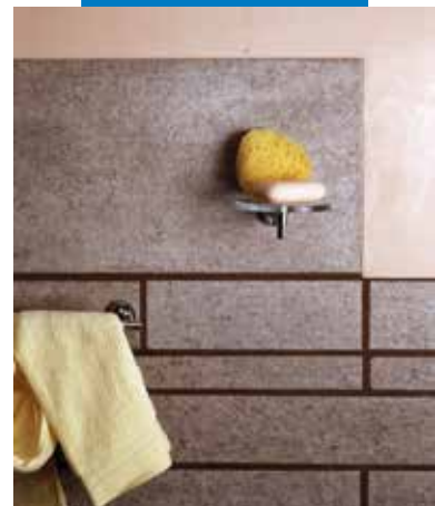
Ultracolor Plus-szal fugázott porcelán falburkolat
