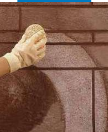
Fugák tisztítása és végtisztítása szivaccsal
