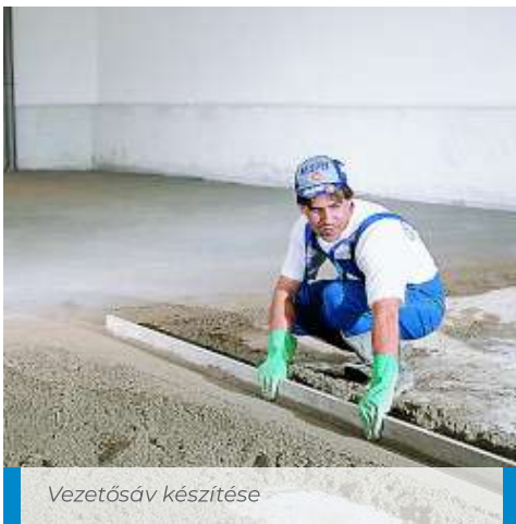
Topcem esztrich bedolgozása
