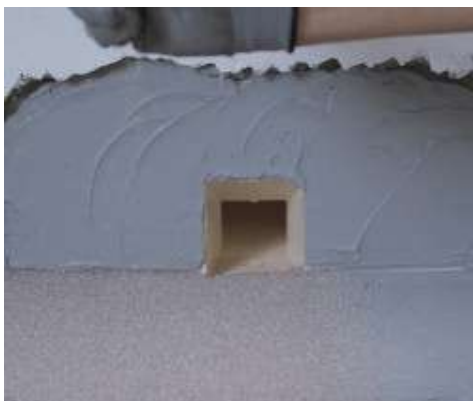
Csatorna vízszigetelése Drain Front-tal
