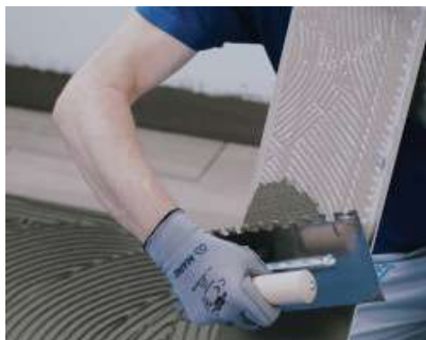
Kerámia vagy kő burkolat fektetése a megfelelő, legalább C2-es MAPEI ragasztóval
