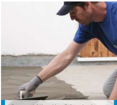
Ragasztó felhordása 5-ös számú fogazott simítóval
