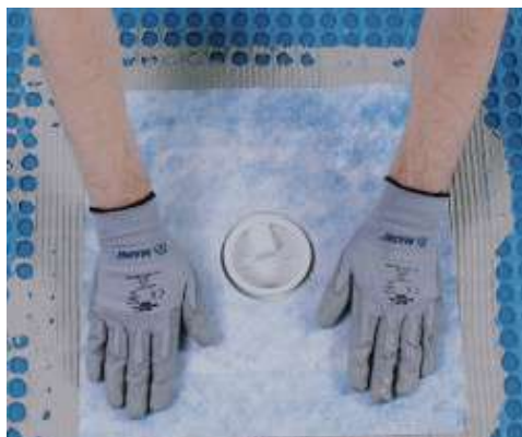
Lefolyók vízszigetelése Drain Vertical/Drain Lateral-lal
