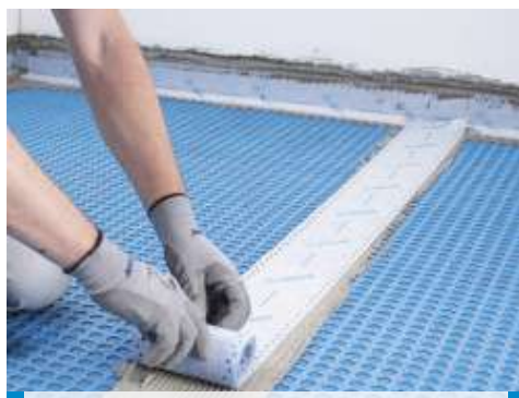
Lemezek közötti csatlakozások vízszigetelése Mapeband Easy-vel, Mapeguard WP ragasztóval ragasztva
