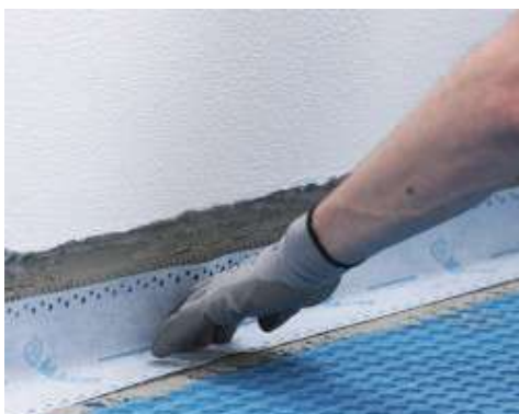
A szélek vízszigetelése Mapeband Easy-vel, Mapeguard WP ragasztóval ragasztva
