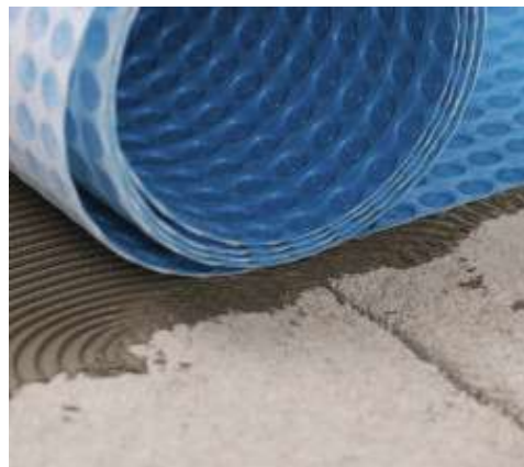
A Mapeguard UM 35 fektetése
