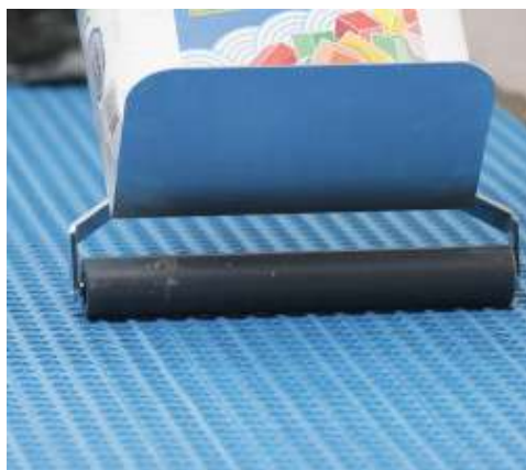
Mapeguard UM 35 lehengerezése
