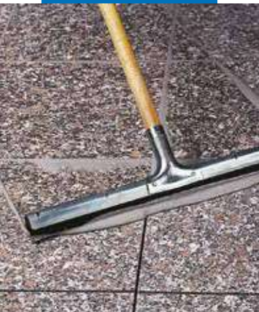
Előcsiszolt és fényezett gránitpadló fugázása gumilehúzóval
