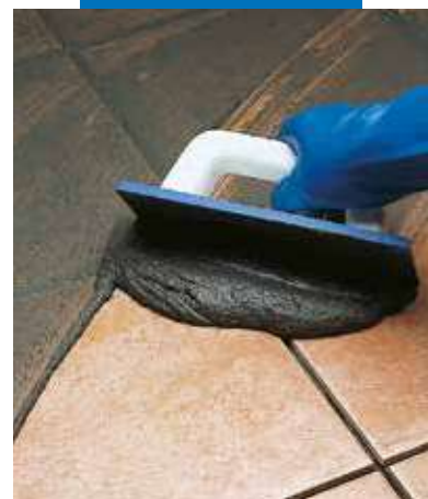
Egyszer-égetett burkolólap fugázása simítóval
