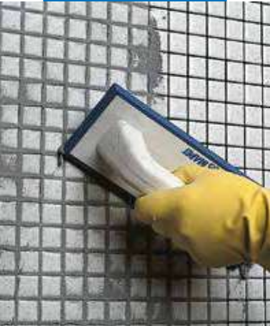
Üvegmozaik (fürdőszoba) fugázása simítóval
