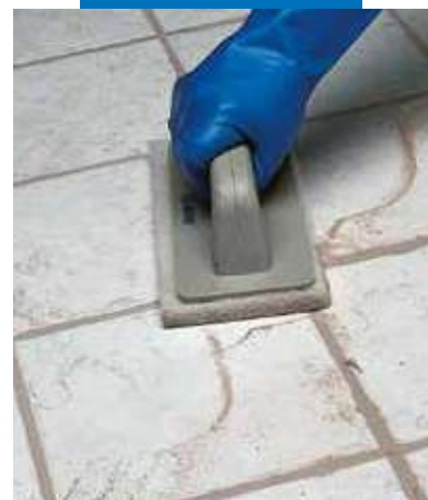
Tisztítás Scotch-Brite® súrolószivaccsal
