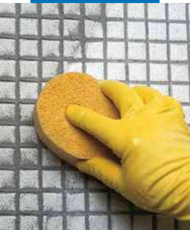
Üvegmozaik tisztítása szivaccsal
