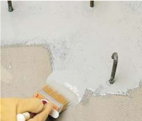
Eporip felhordása munkahézag kötőhídként
