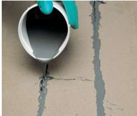
Cementkötésű esztrich repedésjavítása Eporip-pel
